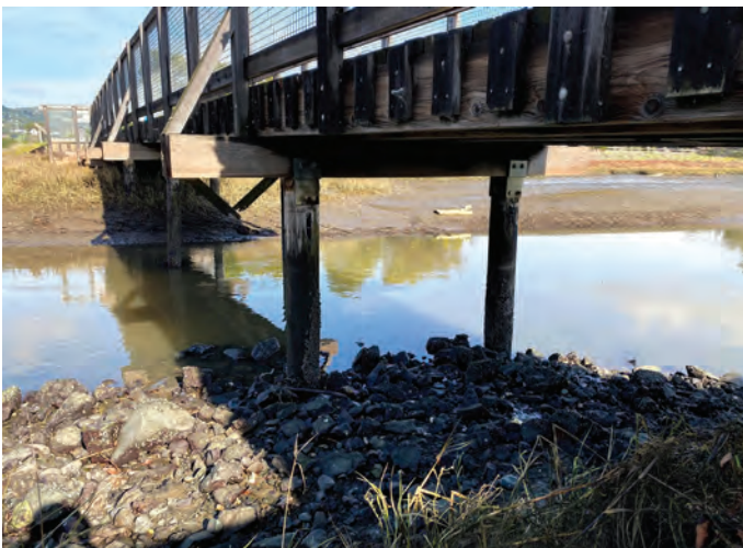
BRIDGE 3 - ARROYO CORTE MADERA DEL PRESIDIO
