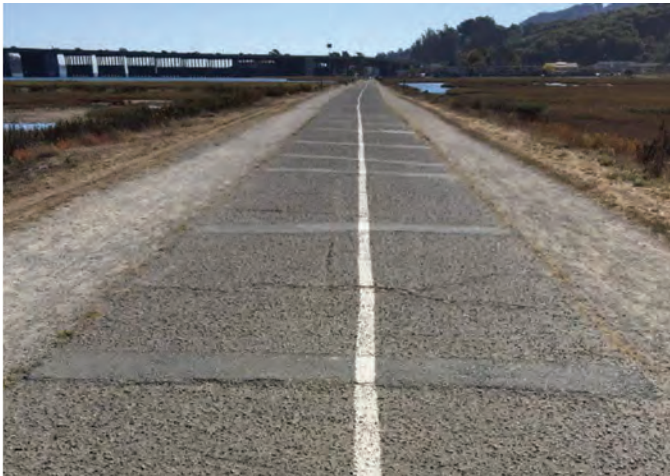
THERMAL CRACKING
